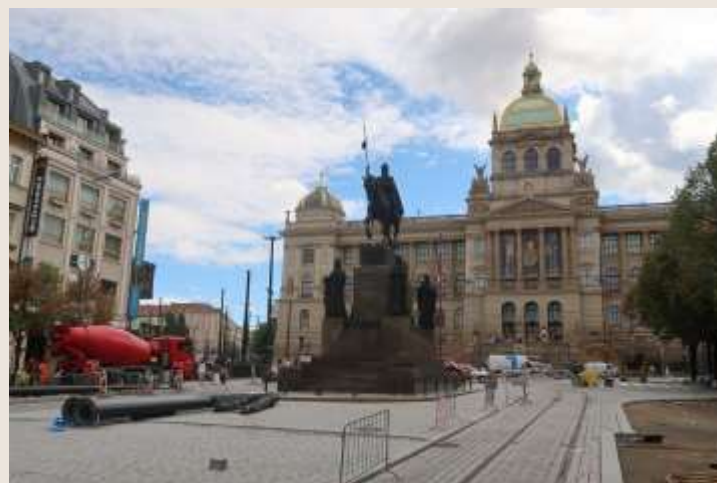
Václavské náměstí – stavba 09/2026
